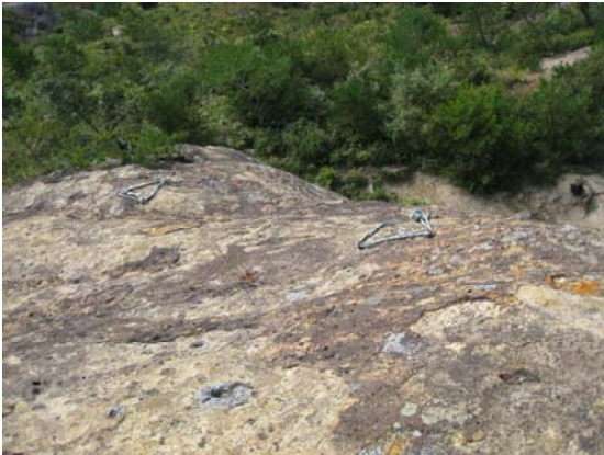
現状終了点写真 作業エリア3の終了点
