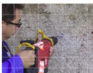
古いボルトを撤去し穴を拡張しているところ
