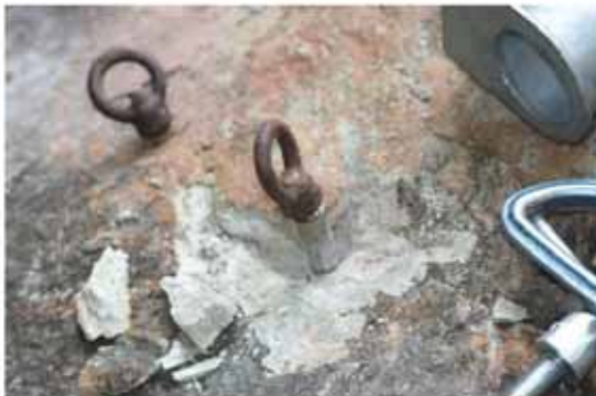
抜けたアンカーを元の場所に立てた
