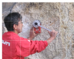
引き抜きテストのために加重している
