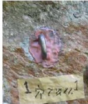
(b) ケミカルアンカーを設置。
