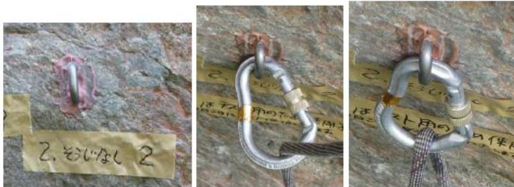
(a)ケミカルアンカーを設置。
