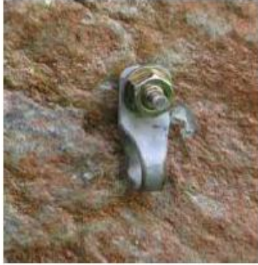
(a) 設置されたオールアンカー
