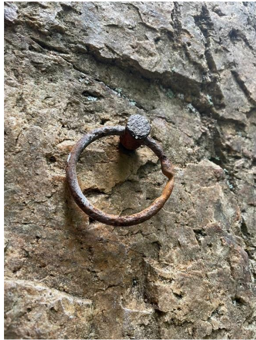
スカイフレーク下部のリングボルト
